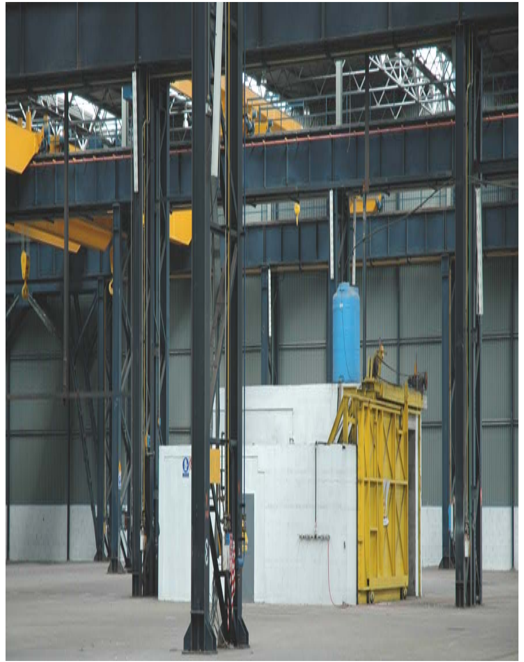
Corpo principale Bunker radiografico interno
