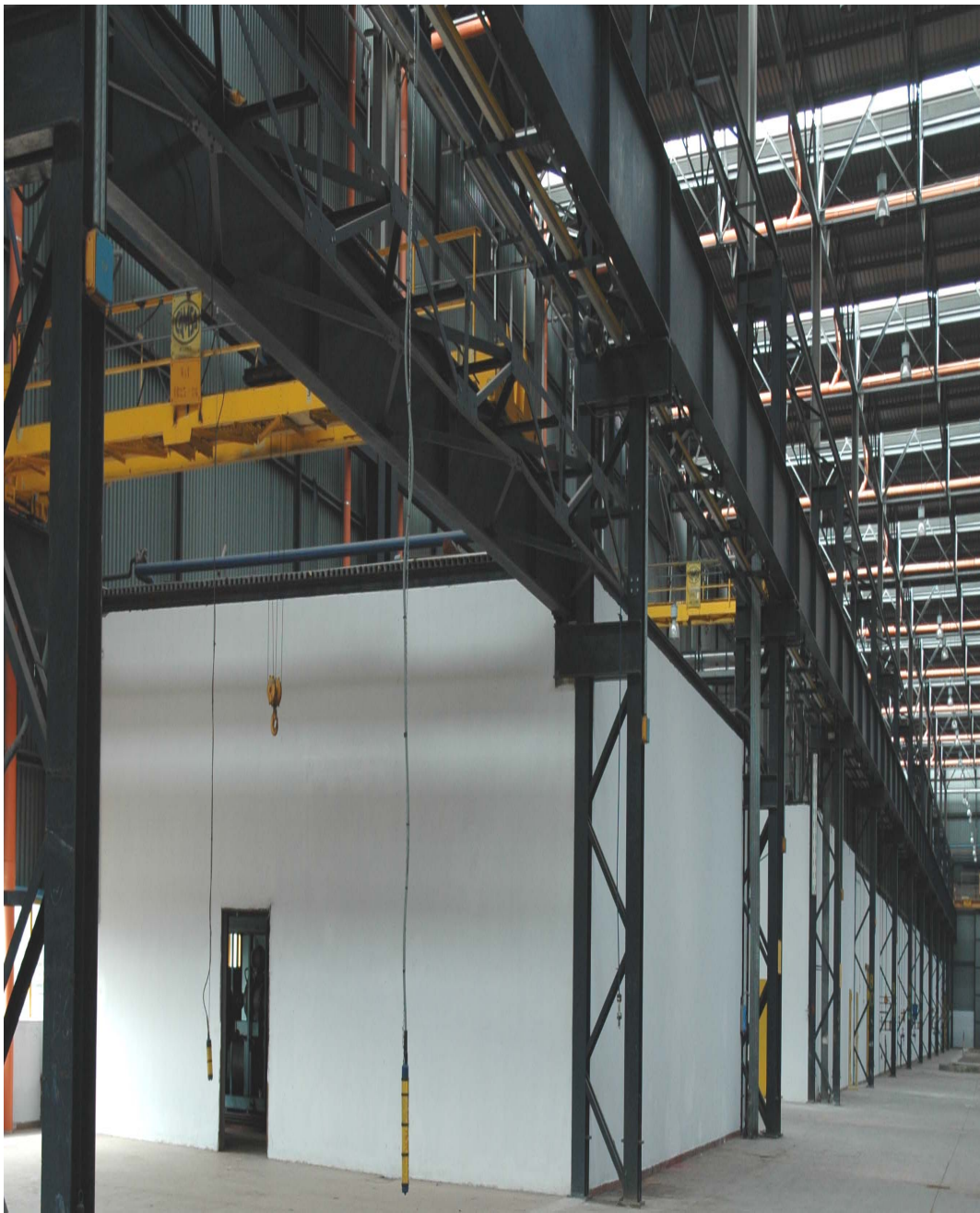
Corpo principale Centrale compressione aria
