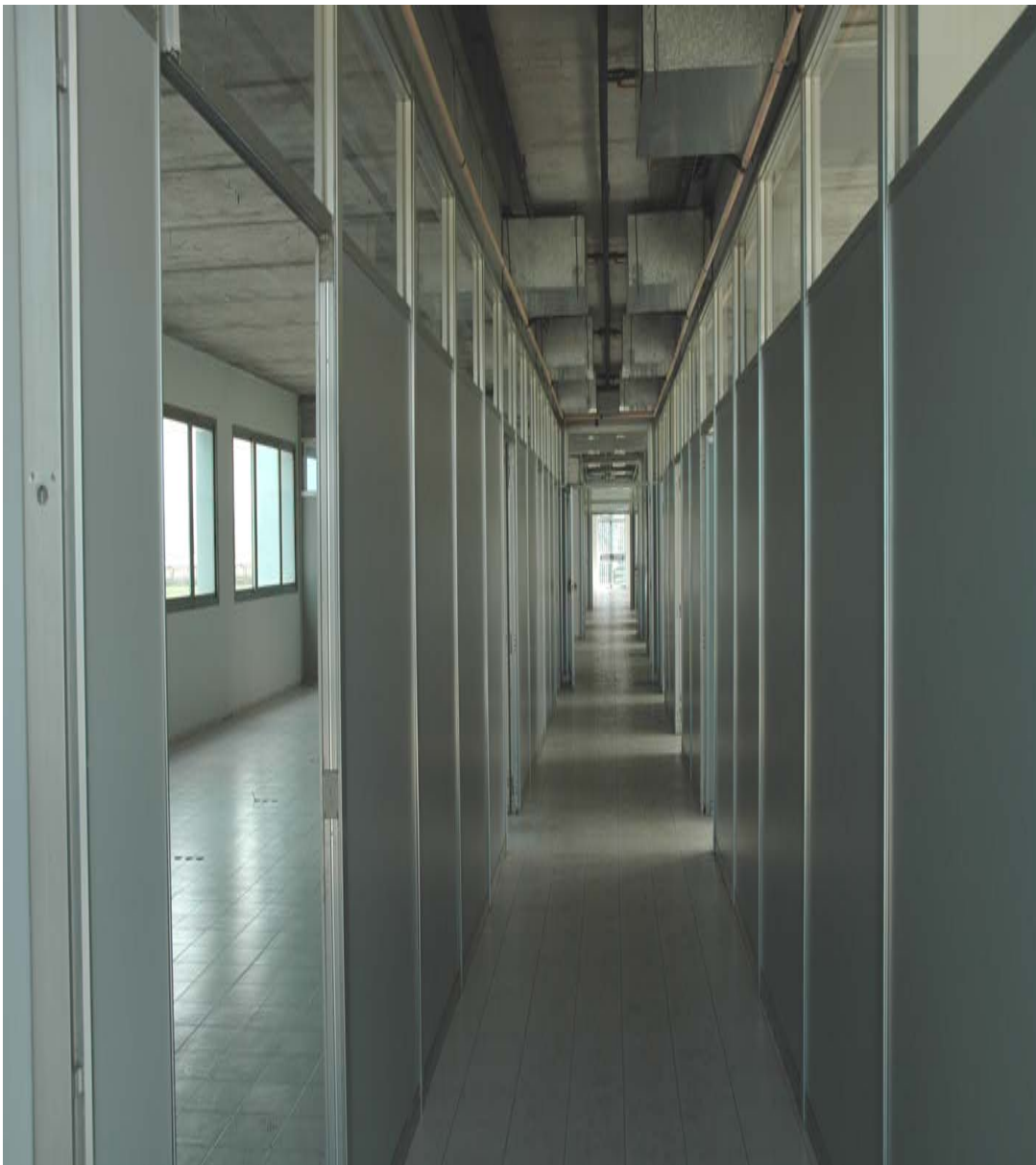
Edificio civile, già Direzione e uffici (mq 617x3) Interno, 1° piano
