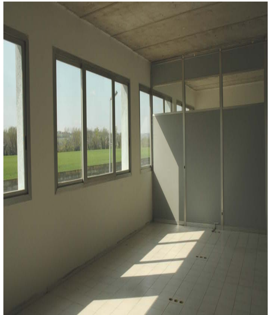
Edificio civile, già Direzione e uffici (mq 617x3) Interno, 1° piano
