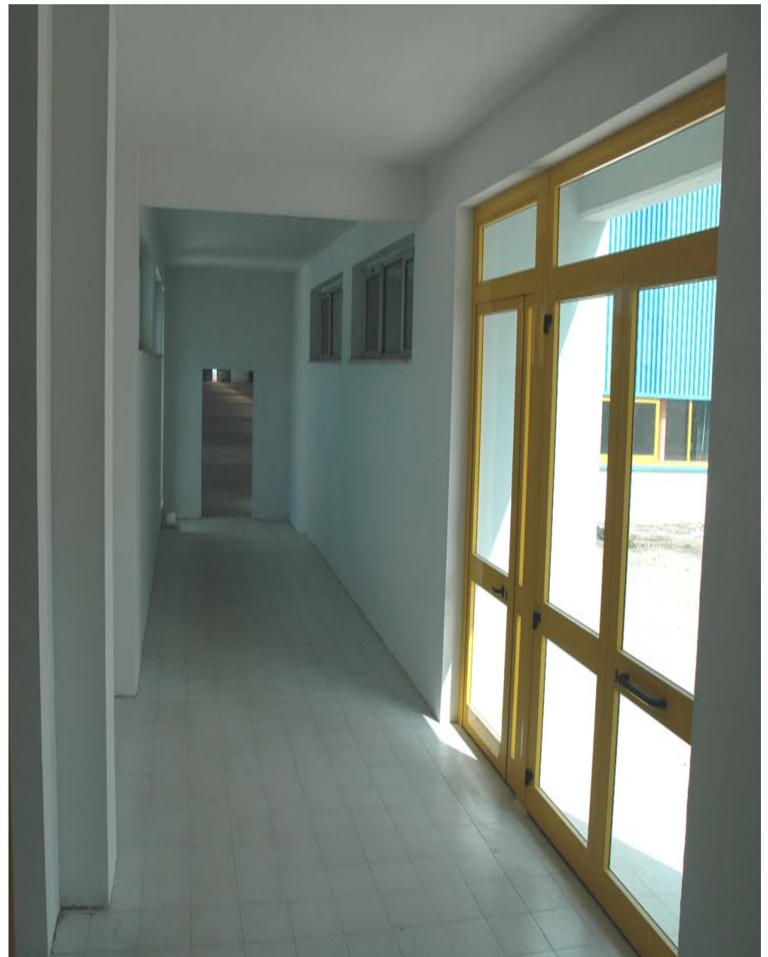
Edificio civile, già servizi operai (mq 470x2) Ingresso
