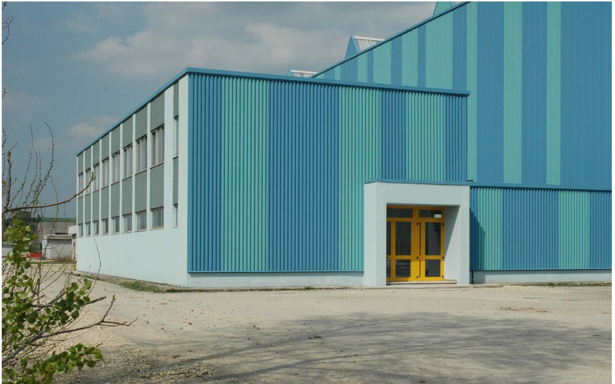
Edificio civile, già servizi operai (mq 470x2) Vista esterna, lato ovest
