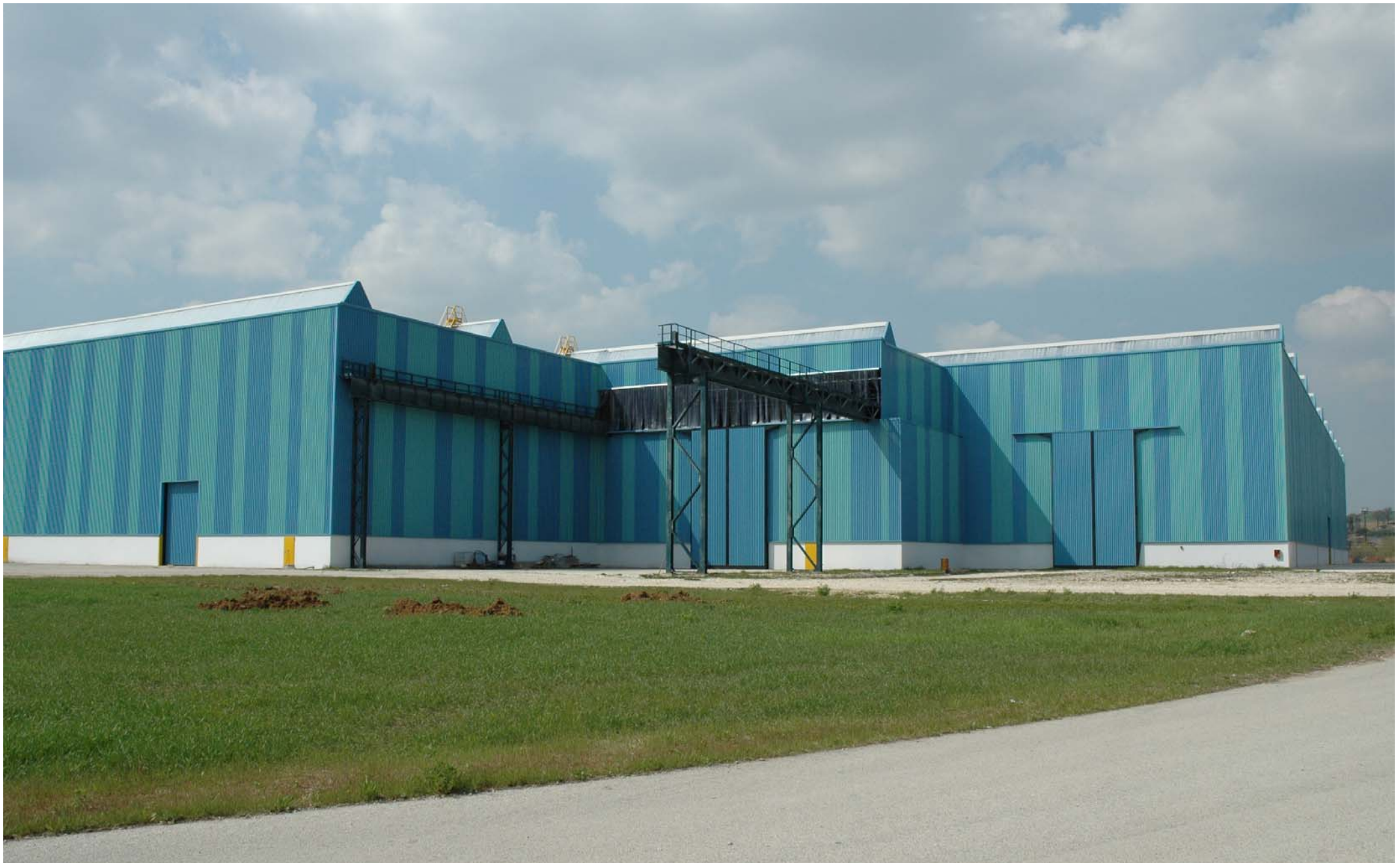
Corpo principale (mq 29.835) Vista esterna, sul lato sud-est
